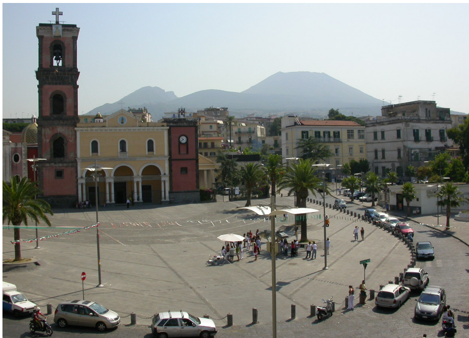
Stato di fatto attuale a fine lavori a inizio anni 2000
